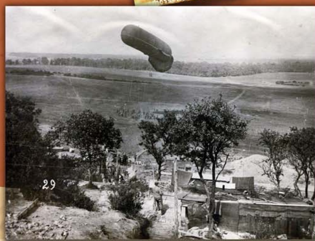
Auf einem freien Feld vor einem Unterstand lassen Soldaten während einer Gefechtspause einen Fesselballon aufsteigen. Die Ballone wurden genutzt, um die entfernt liegenden feindlichen Stellungen zu erkunden und zu fotografieren.
